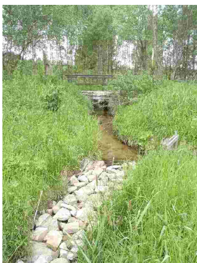
Trop plein du canal
