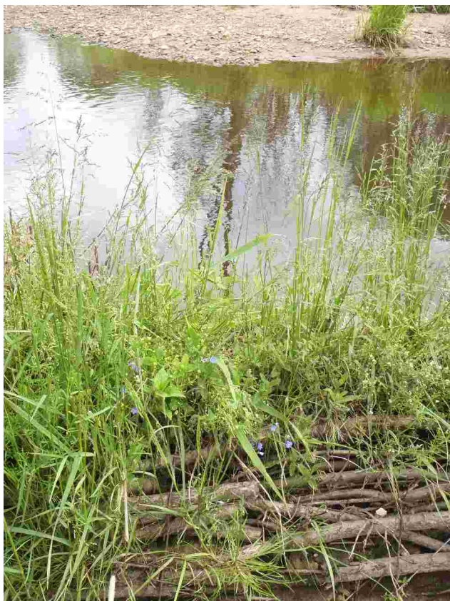
Fixation des berges par un tressage de branches et de terre
