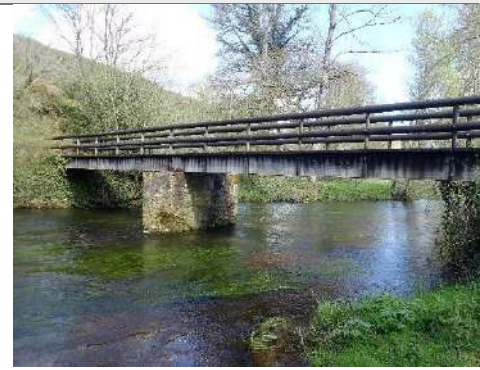
Ouvrage sans impact et franchissable
